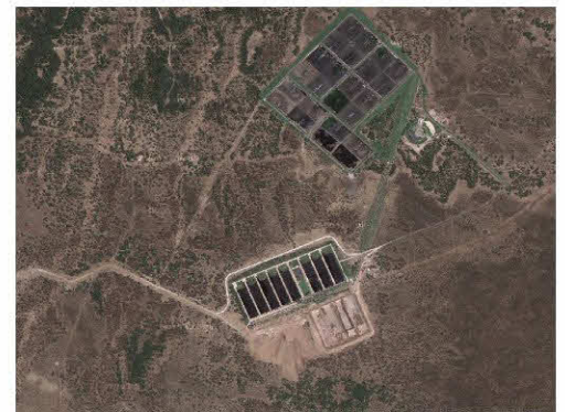
Vue générale de la station de M'Zar
