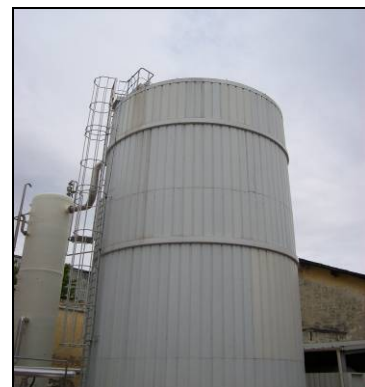
Chais Beaucairois ( 30 ) Méthaniseur technologie UASB type EGSB
